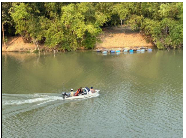
รูปที่ 15 สำรวจระดับพื้นท้องน้ำและการบันทึกข้อมูลด้วยโปรแกรม HYPACK
